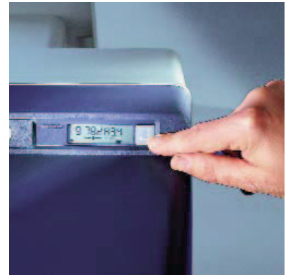
Цифровой менеджер горения упрощает запуск и настройку горелки
